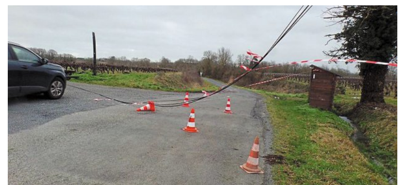
À Gorges, un poteau téléphonique s'est brisé au croisement de la route du Bois-Huaut et de la voie communale qui rejoint Clisson. Des fils traînent sur la route, signalés par quelques plots et des lambeaux de rubalise. Chaque matin, les enfants des écoles viennent prendre leur car à l'arrêt tout proche... Piétons, cyclistes et automobilistes slaloment pour trouver un passage. L'incident a été signalé aux services concernés... Sans réaction, pour l'instant, entretenant l'inquiétude des riverains.
